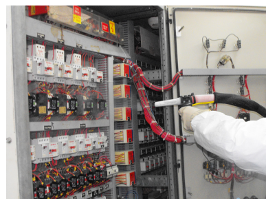
Elektrische Schaltkastenreinigung
